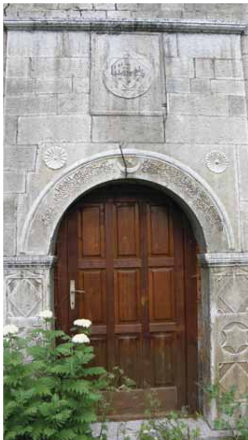
Ulazni portal Bećiragića kule (foto: Halil Markišić)
